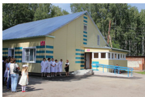
Детское отделение поликлиники в Косихинском районе после капитального ремонта
